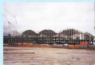
The Airport Terminal in construction. 施工中的機場客運大樓
