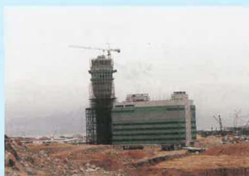
The Airport Central Tower. 機場控制塔
